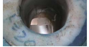
32. 从泵出口处检查叶轮背叶 与泵壳的间隙 ※注①
