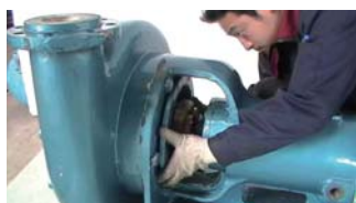
21. 将密封盒调整到冷却水嘴水平对称斜向上的位置
