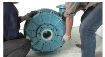
40. 安装泵盖组合
