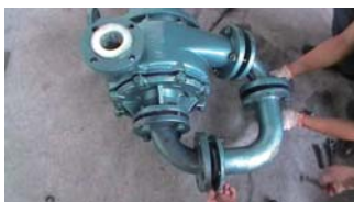
45. 安装弯头接管，注意不要遗漏垫床
