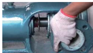
15. 装上装配好的吸入口三通接管组件
