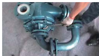
46. 逐一将所有弯头接管螺栓对角均匀拧紧
